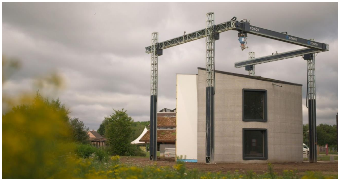
Obr. 1 KampC - Dvoupatrový dům vytvořený 3D tiskárnou BOD2 [3]
