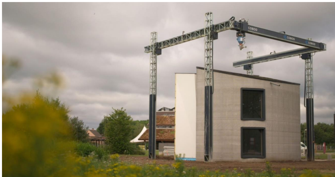
Obr. 1 KampC - Dvoupatrový dům vytvořený 3D tiskárnou BOD2 [3]
