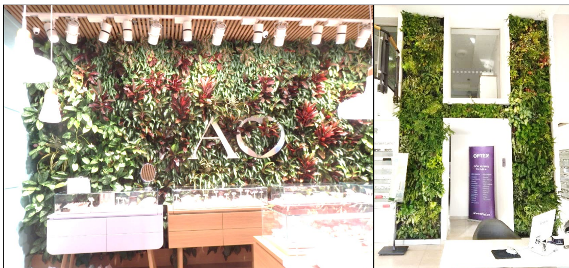
Obr. 20. Zelená stěna ve zlatnictví OC Aupark Hradec Králové (vlevo) | realizace zelené stěny v optice Hradec Králové (vpravo)
