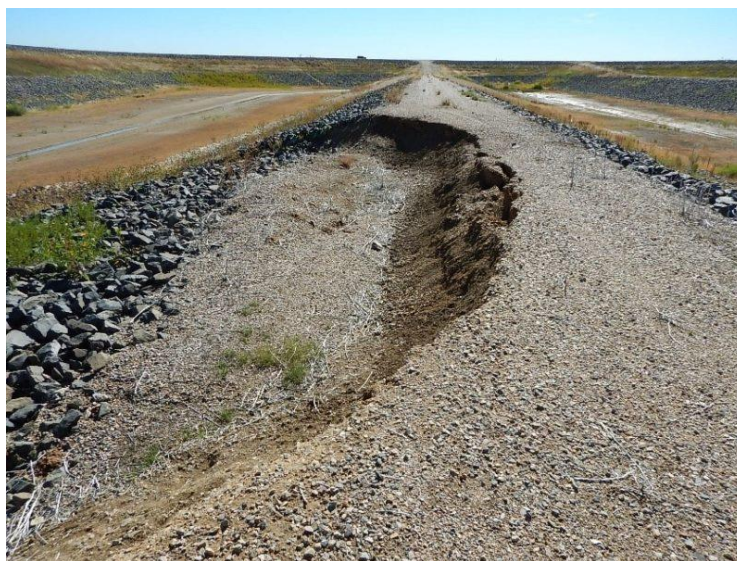
Obr. 4.3 Ztráta stability na vzdušní straně hráze (ASDSO, 2021)
