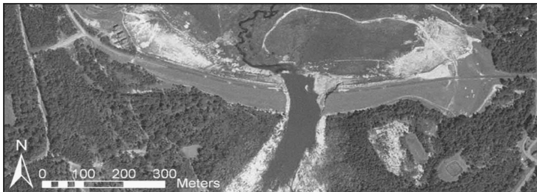
Obr. 8.37 Reálné protržení Big Bay, 2004 – půdorysný pohled na protrženou hráz (Ferguson a kol., 2004)
