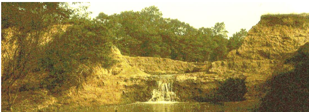
Obr. 4.2 Tvar průlomového otvoru v hrázi VD Hvozdná (VD – TBD, 2021)
