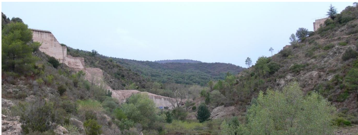
Obr. 1.1 Protržená betonová hráz přehrady Malpasset, Francie, autor Jaromír Říha
