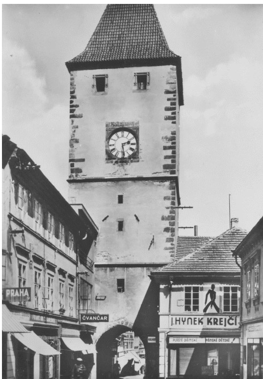
Obr. 4 Pražská brána, pohled od hlavního náměstí po přestavbě podle architekta Kamila Hilberta z let 1916 – 1920.
