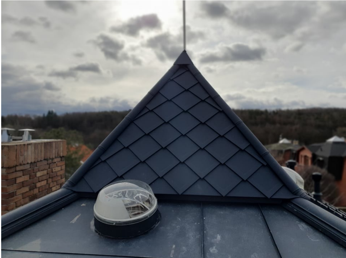
Obr. 4.23 Světlovod zabudovaný do falcované krytiny
