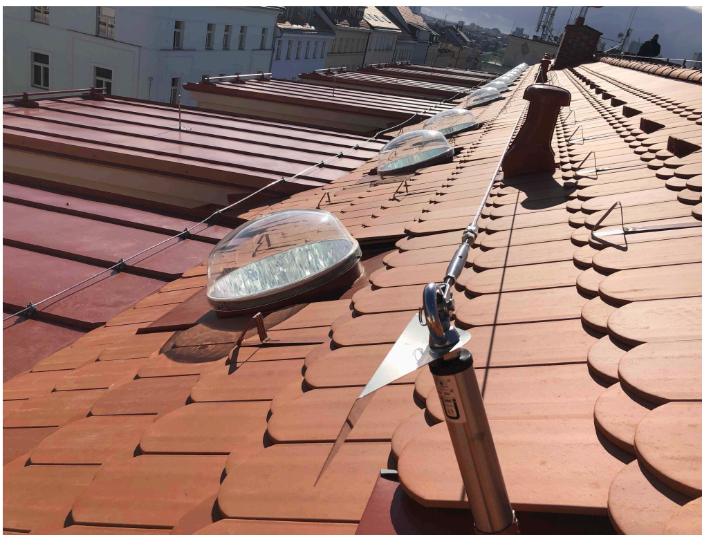
Obr. 4.22 Řada nadstřešní kopulí tubusových světlovodů instalovaných do skládané střešní krytiny
