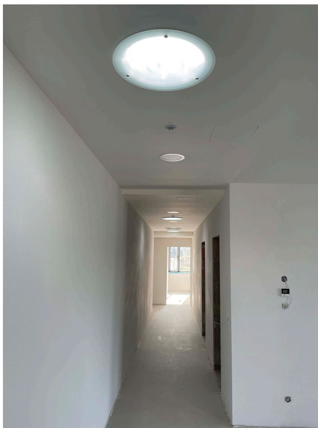
Obr. 4.17 Instalace světlovodů průměru 350 mm na chodbě v rezidenčním objektu
