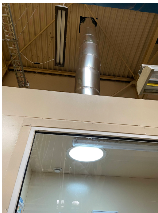
Obr. 4.19 Instalace světlovodu do halového kancelářského vestavku
