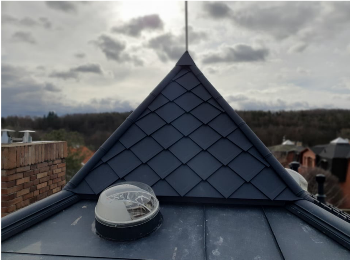
Obr. 4.23 Světlovod zabudovaný do falcované krytiny
