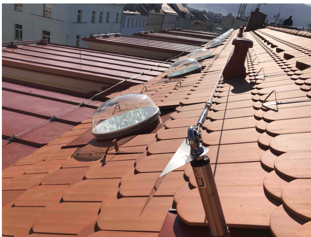
Obr. 4.22 Řada nadstřešní kopolů tubusových světlovodů instalovaných do skládané střešní krytiny
