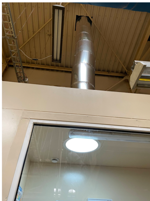
Obr. 4.19 Instalace světlovodu do halového kancelářského vestavku
