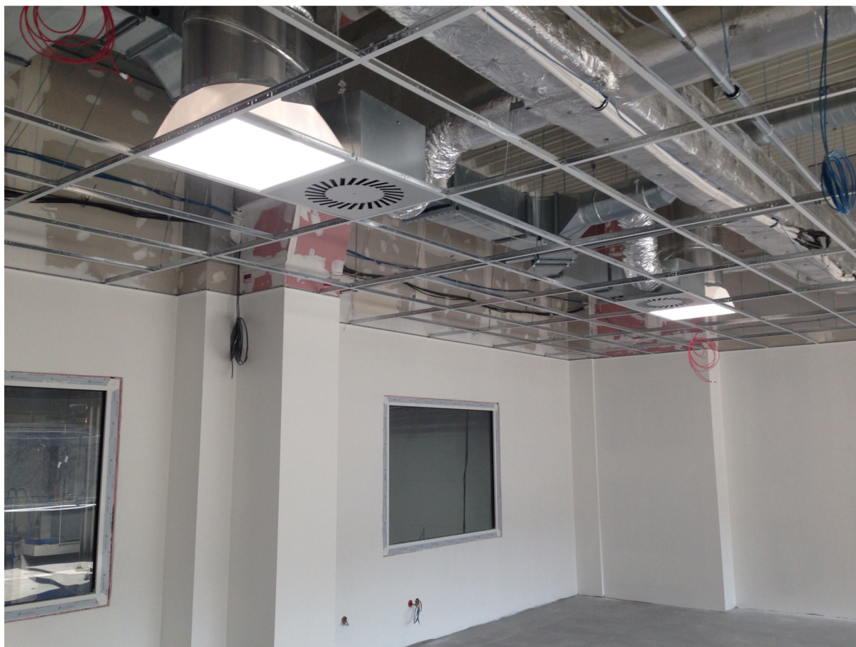
Obr. 4.18 Instalace světlovodů průměru 530 mm, použití přechodového kusu do rastru sádrokartonového podhledu
