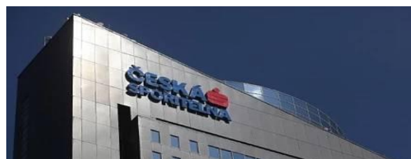
Obr. 4 Sídlo ČS v Praze
