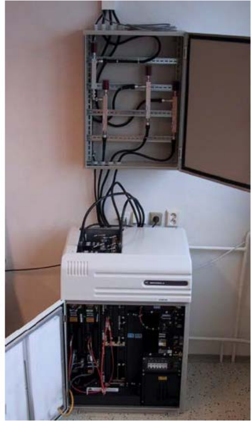
Obrázek 7: Základnová stanice EGSM (zdroj: www.motorolasolutions.com )
