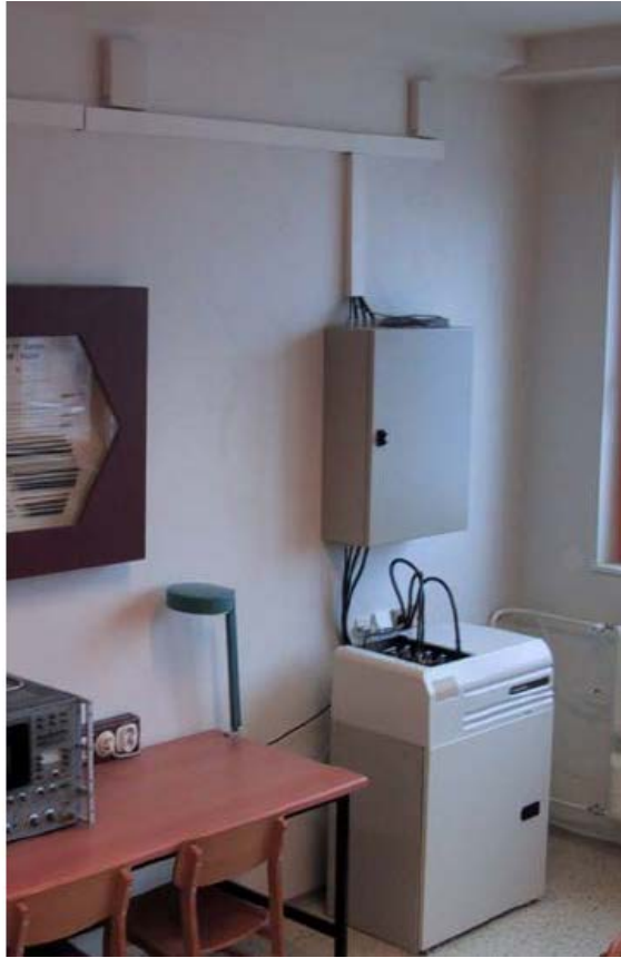
Obrázek 7: Základnová stanice EGSM (zdroj: www.motorolasolutions.com )
