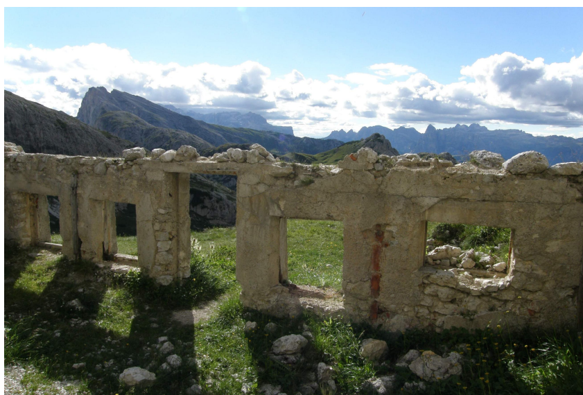
Obrázek 1: Zbytky zděného opevnění
