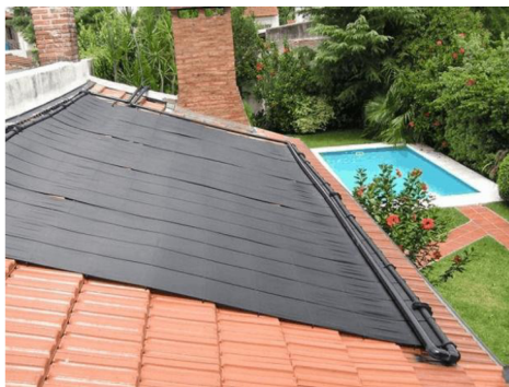
Obrázok 3 Plochý nekrytý kolektor na ohrev bazénovej vody [9]
