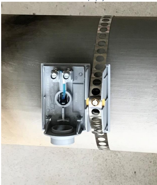
Obrázek 6 Základová deska s přípojovacími svorkami
