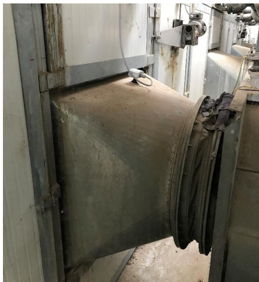
Obrázek 3 Umístění teplotního a vlhkostního snímače na ventilátoru
