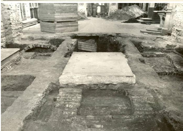
Obr. 4 a 5 – Během rekonstrukce šumperského dominikánského kostela v roce 1993 byly odhaleny vnější stěny podzemní krypty, která v minulosti patrně patřila rodu Žerotínů (foto: soukromý archiv Drahomíra Polácha).
