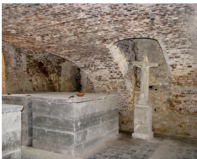
Obr. 20 – prostor zaklenuté krypty pod kaplí zámku v Niemodlinu, doplněný o druhotně přinesený kamenný kříž a několik prázdných novodobých sarkofágů z betonu (foto: Pavel Lasztovicza, 2018).
