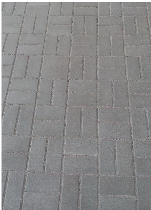
Obrázek 77 Dlažba u budovy A UHK
