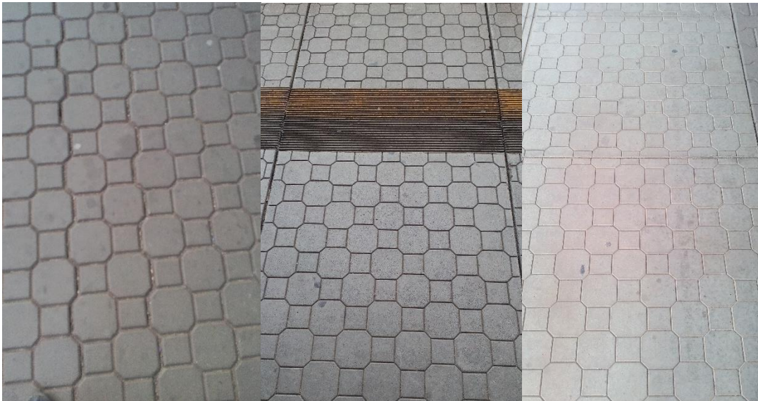
Obrázek 69 Dlažba na nádraží
