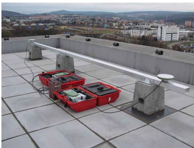
Obr. 8.1: Zaměřování referenčních bodů na střeše budovy E objektu T12
