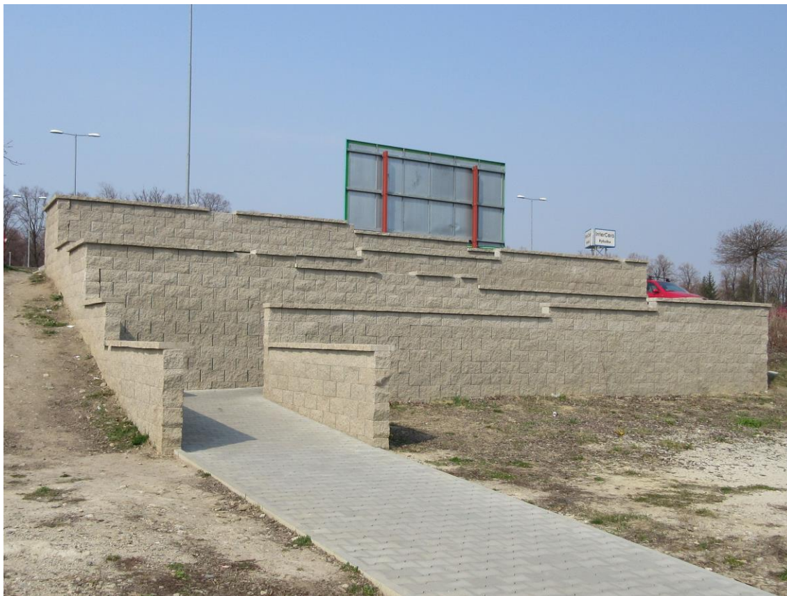
Obrázek 47: Nevydařená rampa u OC InterCora Rybalka
