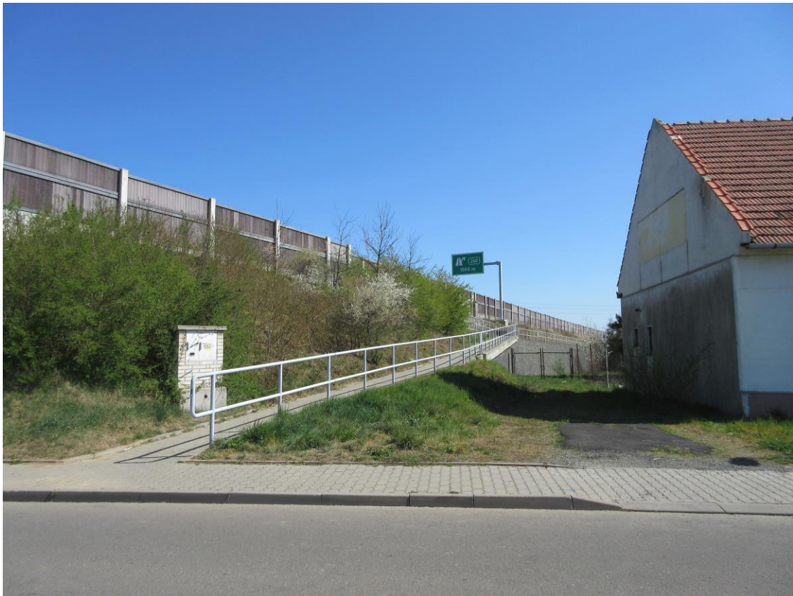
Obrázek 66: Protihluková stěna u dálnice
