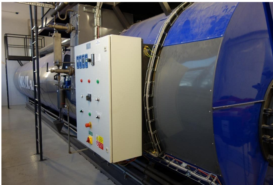
Obr. 3 Kotel s akumulátorom pary [7]
