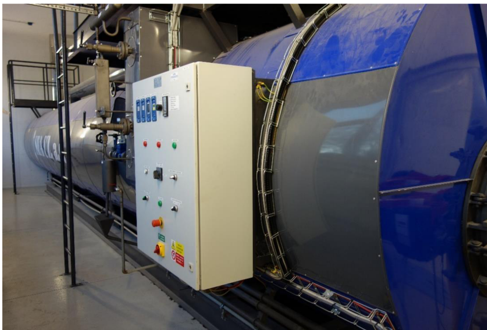
Obr. 3 Kotel s akumulátorom pary [7]
