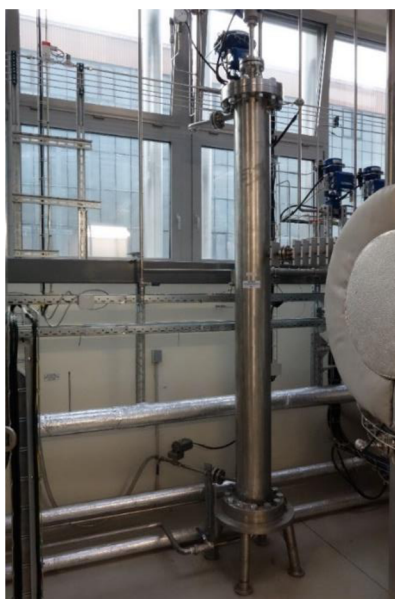
Obr. 4 Mokrú práčku odplynov komory H2 [1]
