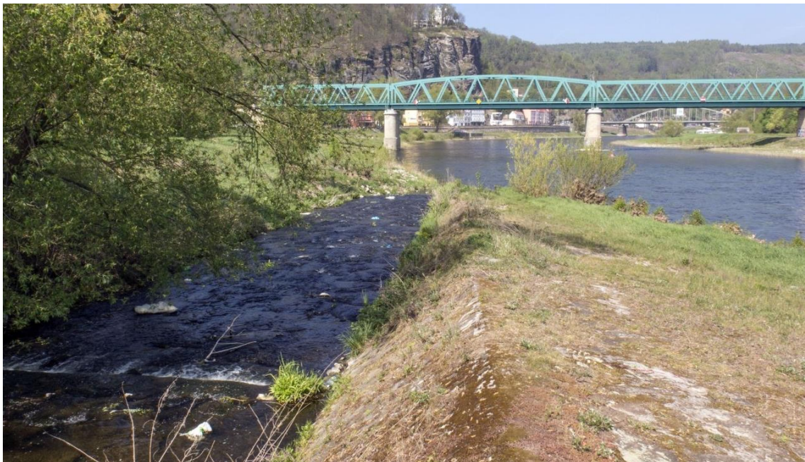
Obrázek 14: Silně regulovaný dolní úsek Jílovského potoka (LJ1) v Děčíně, pohled po proudu (Foto Martin Bláha).
