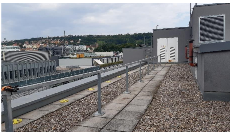
Obrázek 6 – Klasická nezelená střecha budovy hotelu OREA
