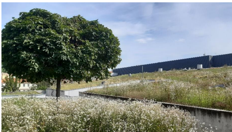
Obrázek 5 – Zelená střecha na budově OC Smíchov
