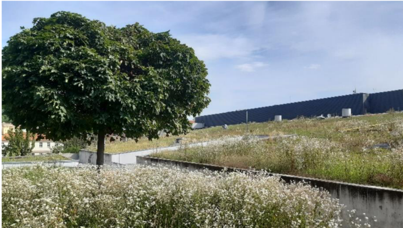
Obrázek 5 – Zelená střecha na budově OC Smíchov
