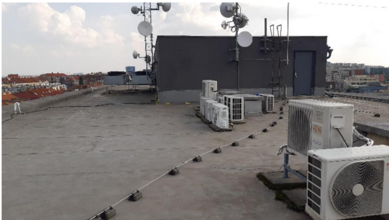
Obrázek 7 – Klasická nezelená střecha administrativní budovy Na Pankráci 30
