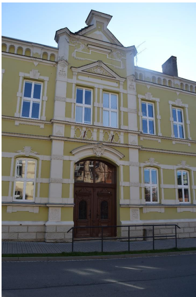
4. Vchod z Jiráskovy ulice – 1. stupeň
