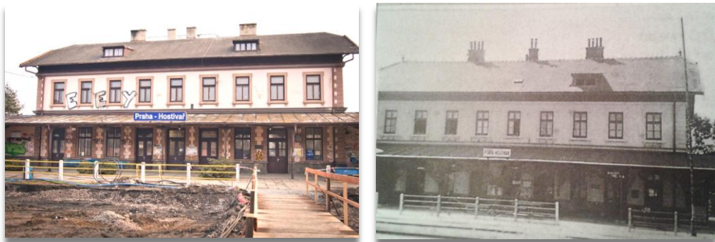
Obr. 52: Nádražní budova v Hostivaři, vlevo současnost, vpravo v 1. pol. 19. století (foto: autorka DP, 2015, zdroj: Augusta, 1998)
