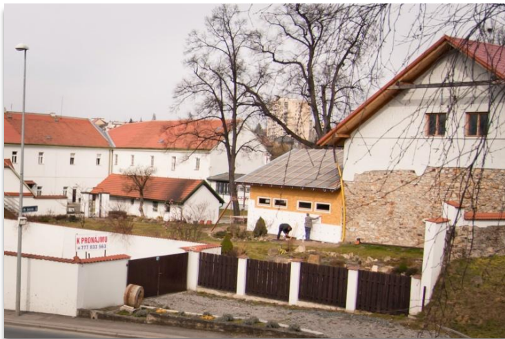
Obr. 45: Vyvýšená zahrada Švehlova statku (foto: autorka DP, 2015)
