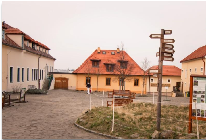
Obr. 38: Domek s vysokou valbovou střechou v Toulcově dvoře (foto: autorka DP, 2015)
