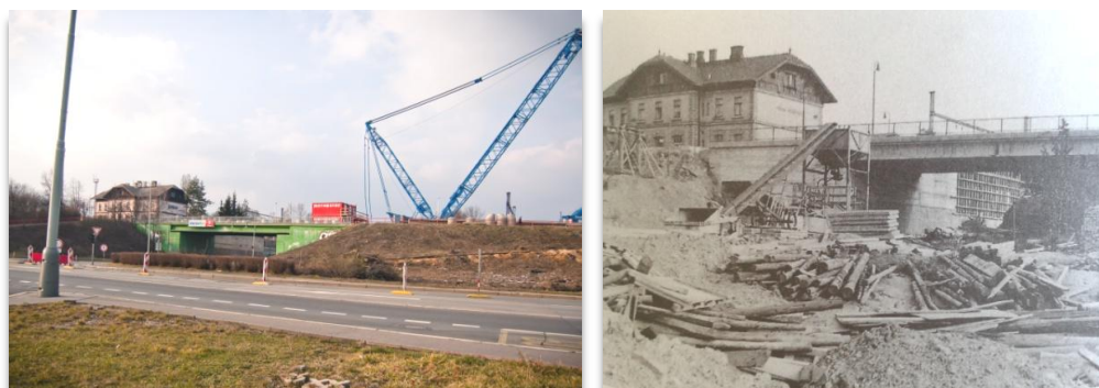
Obr. 12: Podjezd pod železnici, vlevo probíhající rekonstrukce ke dni 15. 3. 2015, vpravo výstavba roku 1976 (foto: autorka DP, 2015, zdroj: Augusta, 1998)
