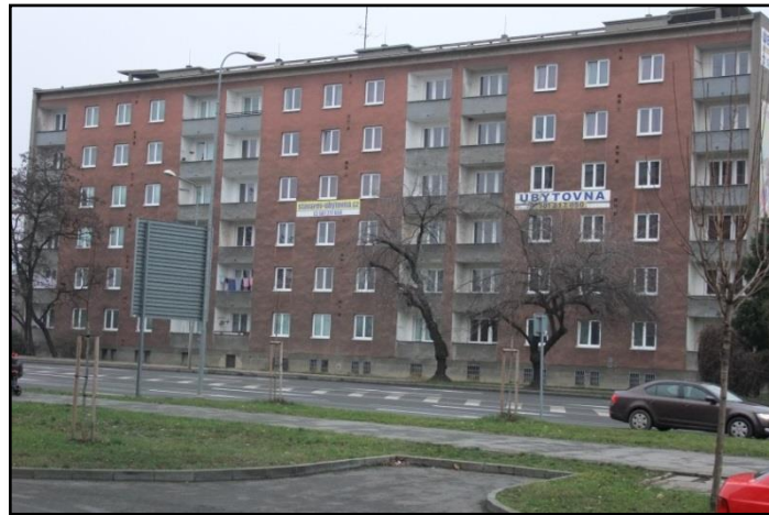
Obr. 9 Ubytovna Stavařov (foto: P. Bouchalová, říjen 2015)
