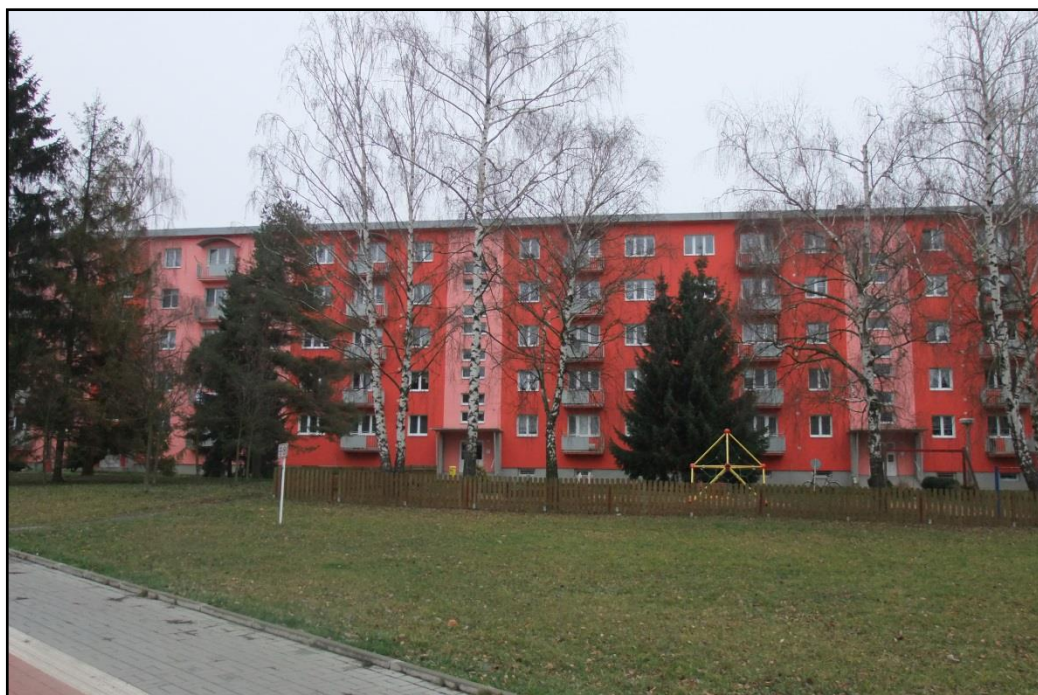
Obr. 11 Želatovská ulice (foto: P. Bouchalová, listopad 2015)
