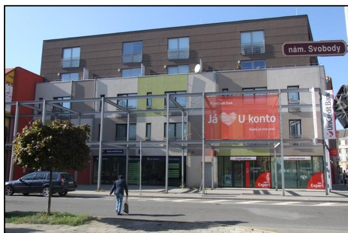
Obr. 12 Nový bytový dům na rohu ulic Čechova Jaselská. (foto: P. Bouchalová, září 2015)
