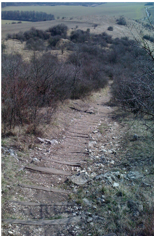
Obr. 64: Zpevnění cesty pomocí schodů (NPR Tabulová)
