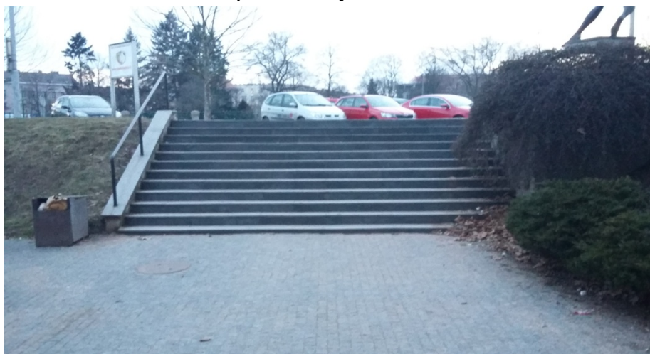
Obrázek 25. Přístup k hlavnímu vchodu
