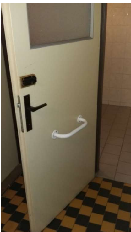
Obrázek 29. Vstup do kabiny WC
