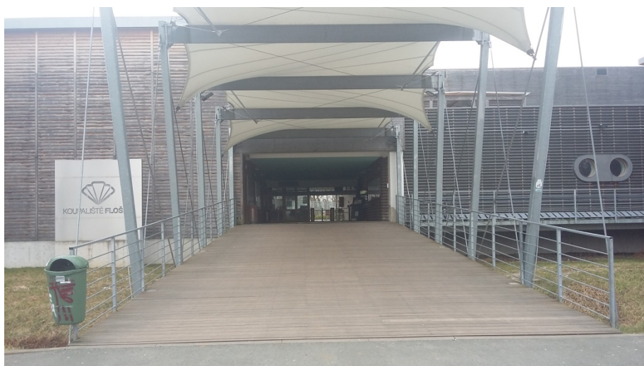
Obrázek 1. Hlavní vstup do objektu
