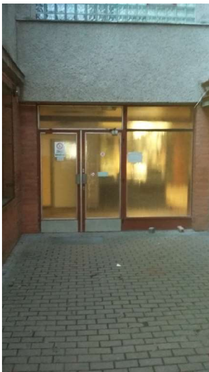
Obrázek 28. Vedlejší vstup do budovy
