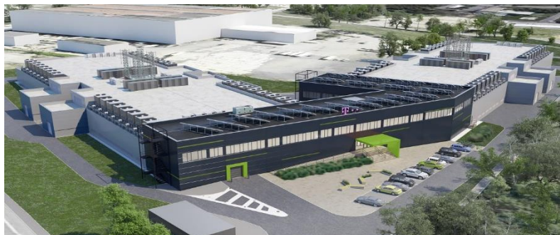
Obr. 11 - pevné datové centrum T-Mobilu (53)
