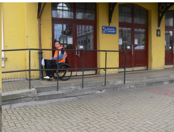
Obrázek 92 Vstup do výpravní budovy z prostoru přednádražní
