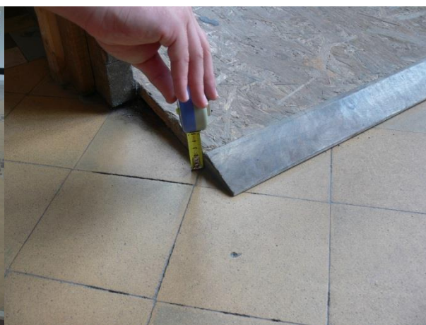
Obrázek 124 Přejchod rampy a podlahy
