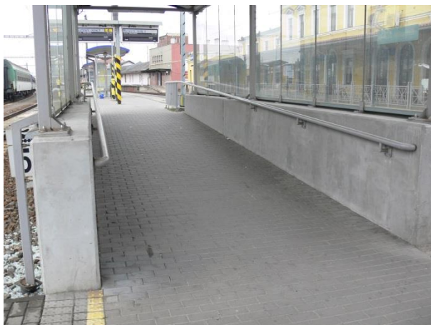
Obrázek 79 Šikmá rampa na poloostrovní nástupiště
