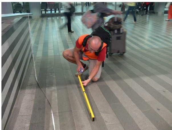
Obrázek 125 Sklon bezbariérové rampy
