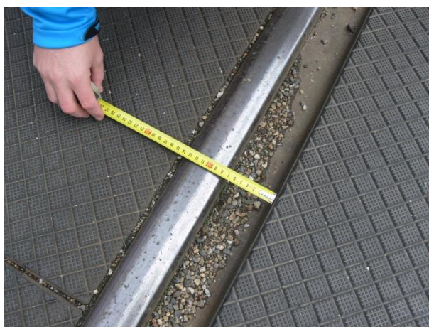
Obrázek 77 Mezera mezi kolejnicí a panelem
