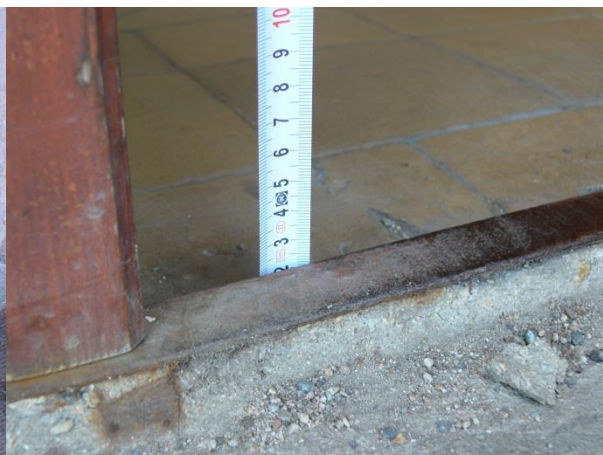
Obrázek 40 Práh ve vstupních dveřích
