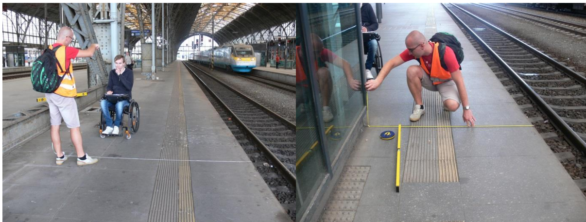
Obrázek 120 Překážky na nástupišti č. 3 – ztužidlové pole
