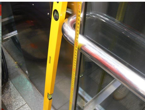
Obrázek 126 Výška madla ve výtahu
