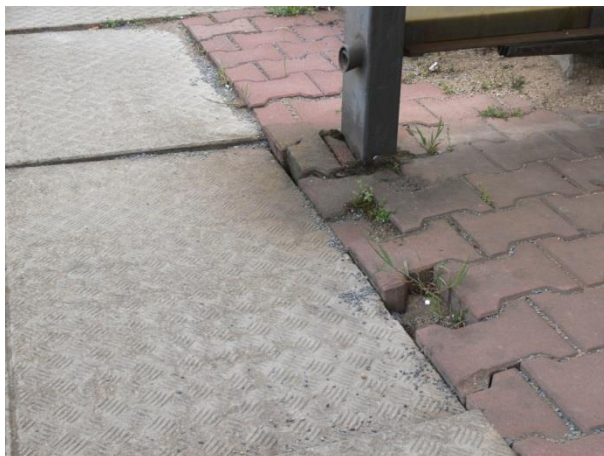
Obrázek 33 Nerovnosti na nástupišti č. 3
