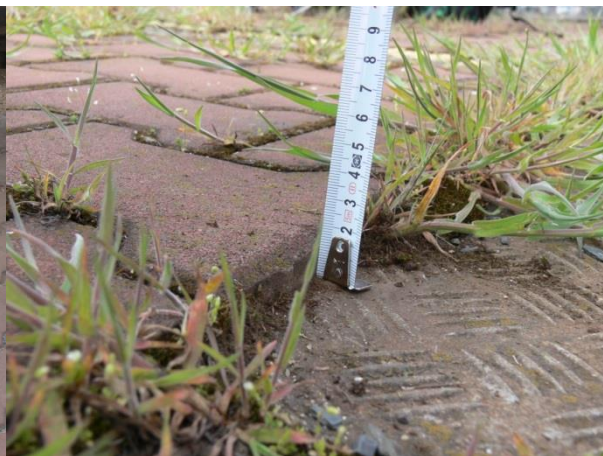
Obrázek 34 Nerovnosti na nástupišti č. 3
