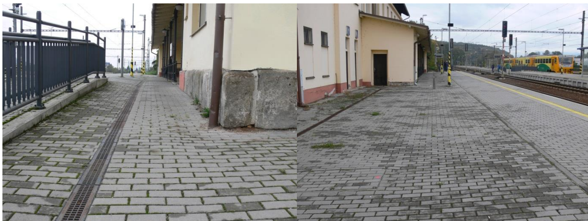
Obrázek 101 Komunikace mezi výpravní budovou a nástupištěm č. 1
