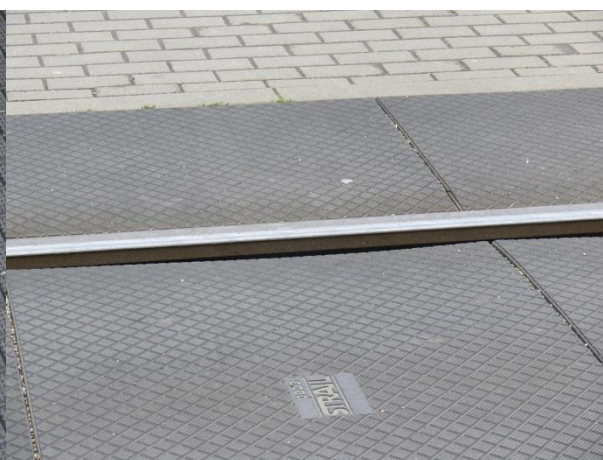
Obrázek 78 Pryžový panel pod kolejnicí
