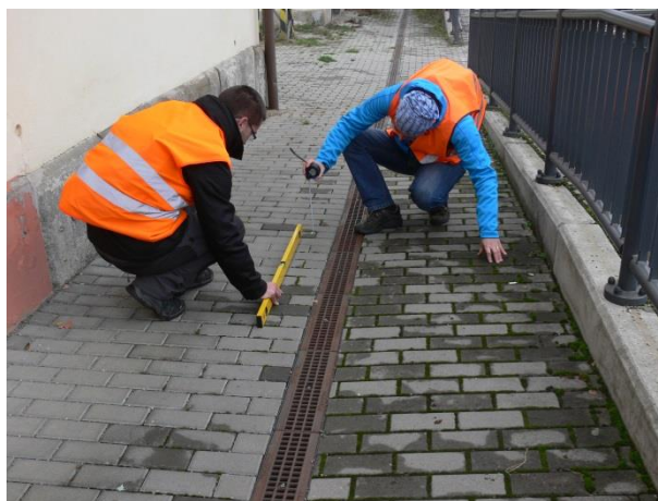
Obrázek 103 Zúžený průchod podél výpravní budovy
