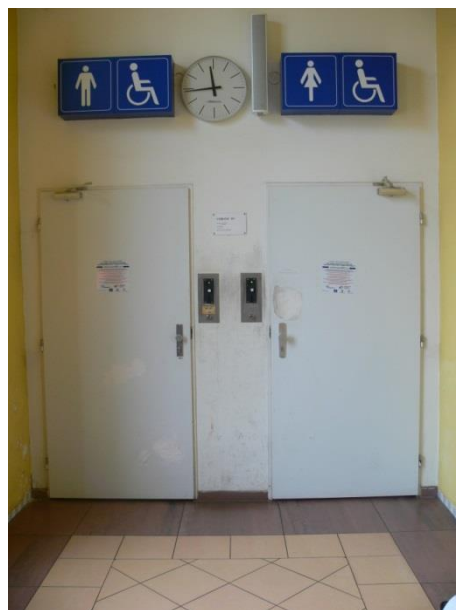
Obrázek 96 Vstupní dveře na toalety
