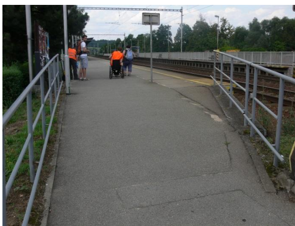
Obrázek 61 Šikmá rampa na nástupiště u koleje č. 1
