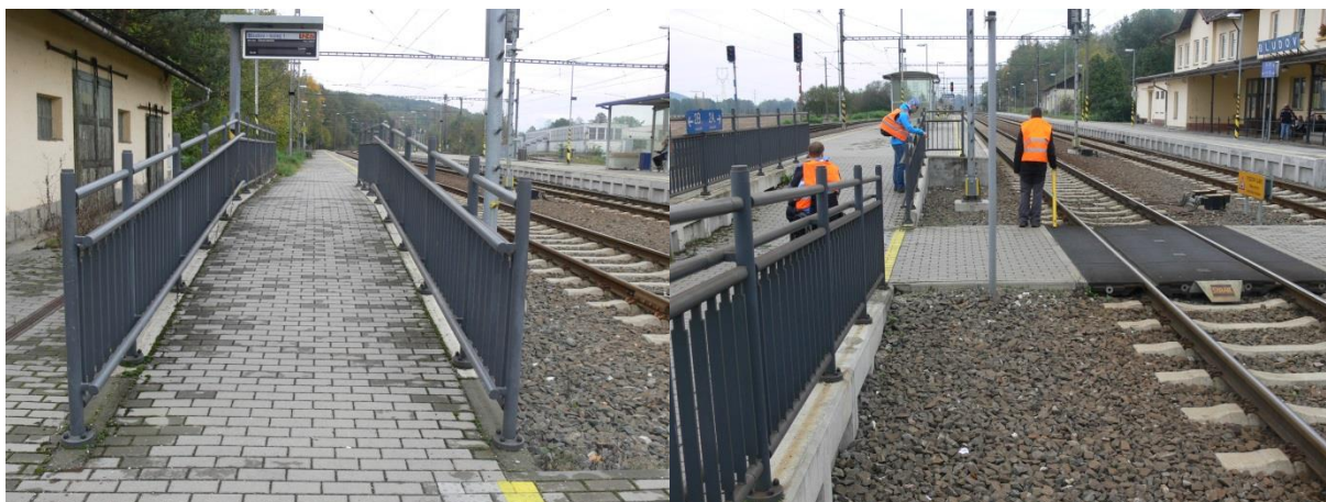
Obrázek 99 Šikmá bezbariérová rampa z centrálního přechodu na nástupiště č. 1
