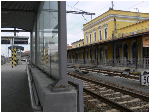
Obrázek 75 Konstrukce zastřešení na centrálním přechodě
