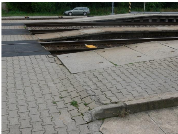
Obrázek 48 Rampy na nástupišti č. 1
