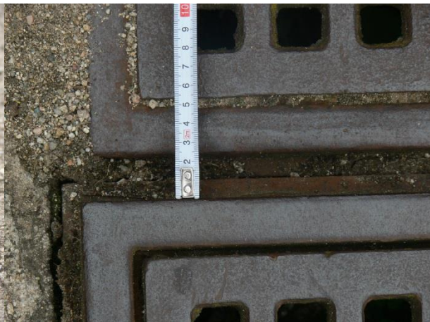
Obrázek 46 Horizontální mezery v místě krytu odvodňovacího zařízení
