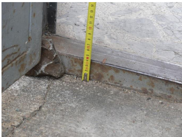
Obrázek 58 Výškový rozdíl ploch ve vstupu do budovy
