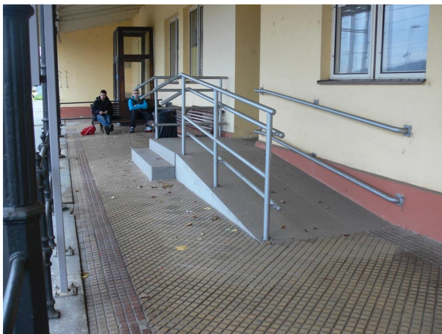
Obrázek 106 Bezbariérová rampa u výpravní budovy
