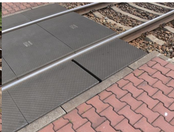
Obrázek 38 Nerovnosti na úrovňovém přechodu v místě pryžových panelů
