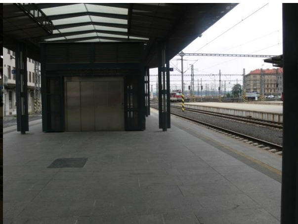
Obrázek 113 Nákladní výtah pod nástupištěním přístřeškem
