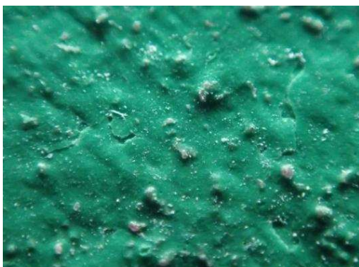
Obrázek 31: Poškození nátěrového systému vzorku Z3PE-M50
