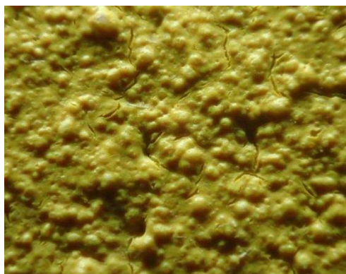
Obrázek 57: Detail lícové strany nátěrového systému 1Z-S po působení M50 a Q08
