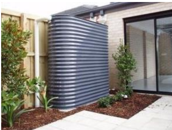
Obr. č. 24 - Nadzemní nádrž na dešťovou vodu (zdroj: Markovič, 2012)
