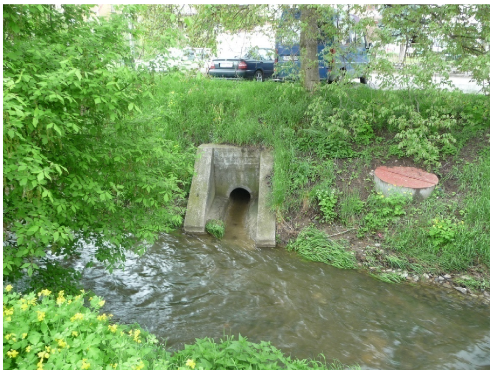
Obr. 7.6 Říční kilometr 11,400 dešťová výpust'
