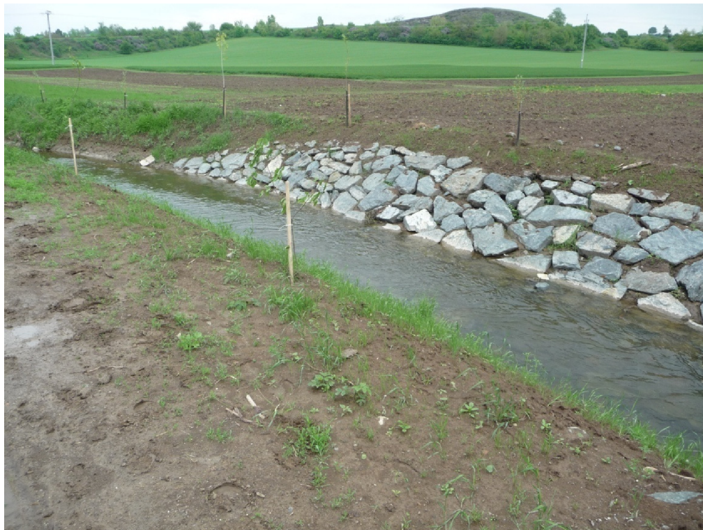
Obr. 7.16 Říční kilometr 13,900 konec opevnění v oblouku
