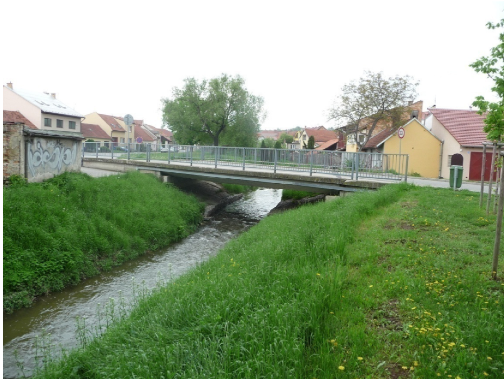
Obr. 7.7 Říční kilometr 11,752 betonový most
