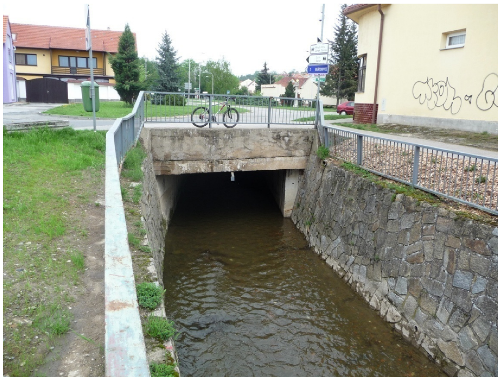
Obr. 7.9 Říční kilometr 12,174 začátek zaklenutí toku
