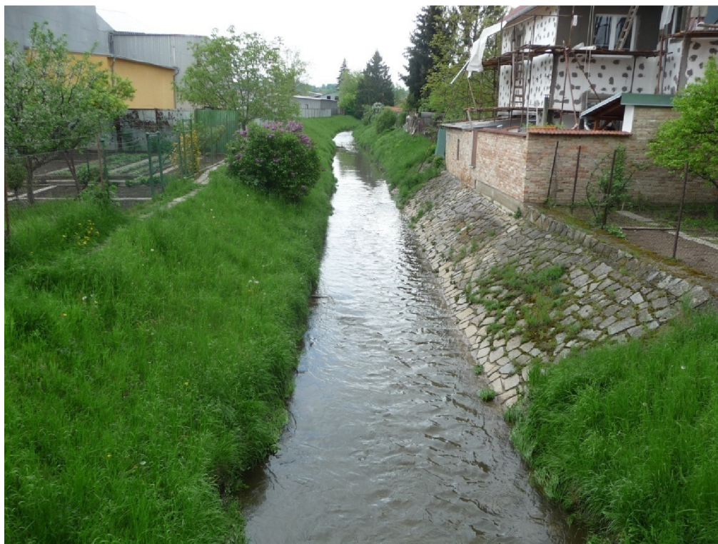
Obr. 7.5 Říční kilometr 11,402 koryto v intravilánu
