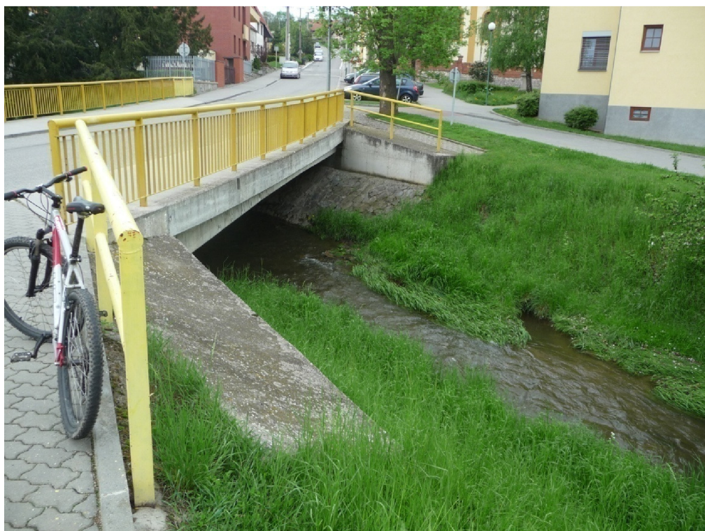
Obr 7.14 Říční kilometr 12,411 betonový most
