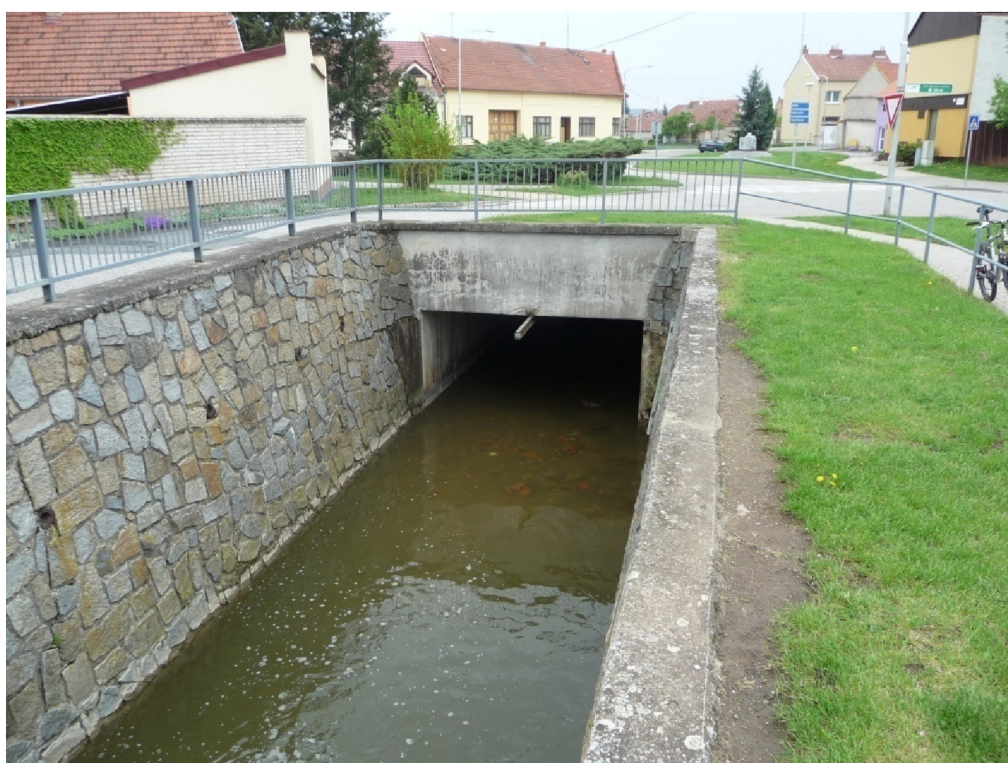
Obr. 7.10 Říční kilometr 12,259 konec zaklenutí toku
