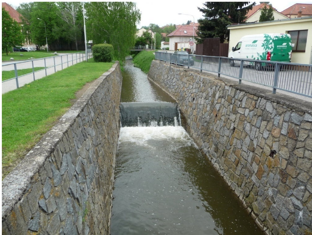
Obr. 7.11 Říční kilometr 12,278 betonový skluz
