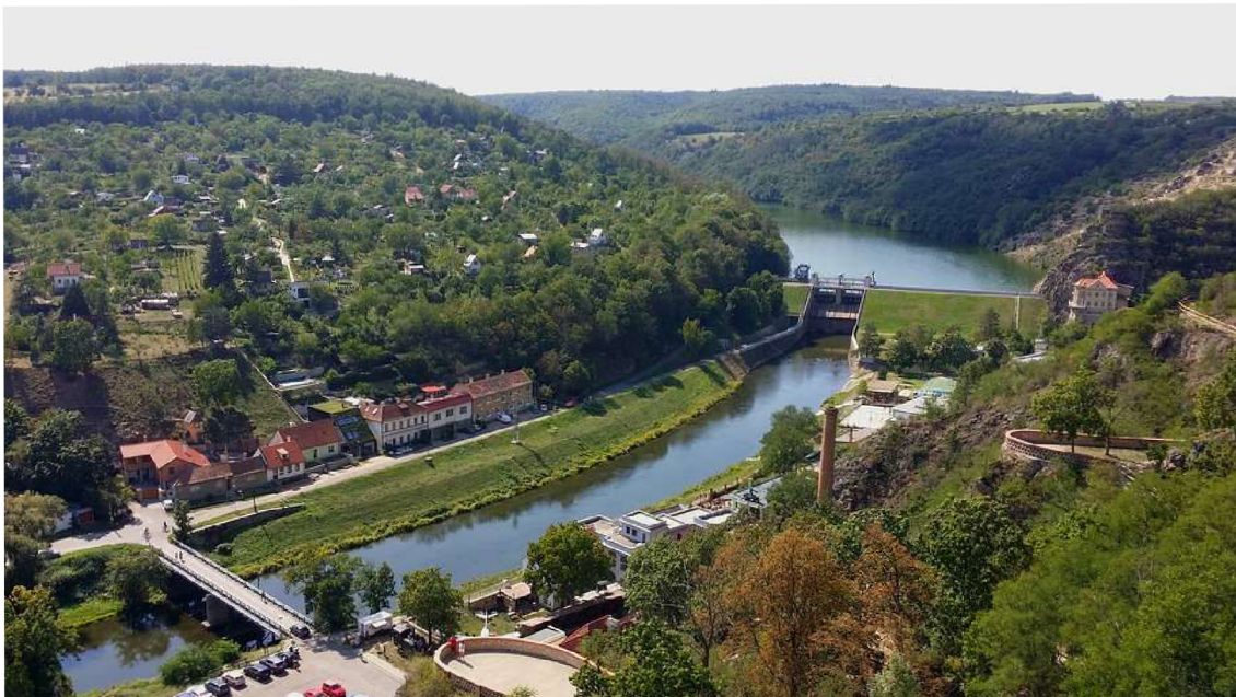
Obr. 19. VD Znojmo – pohled II [32]
