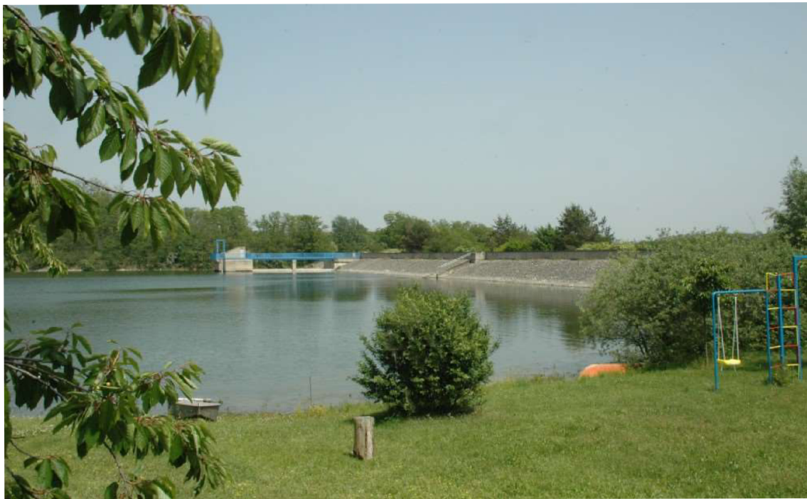
Obr. 13. VD Výrovice – pohled II [25]
