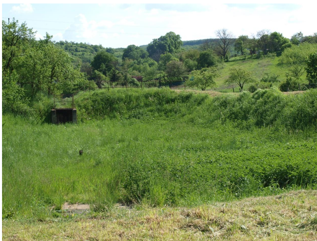
Obrázek 14: "Mezihorky" - hned nad intravilánem u kritického bodu se nachází suchá nádrž, která je během intenzivních dešťových událostí plná a částečně chrání obec.
