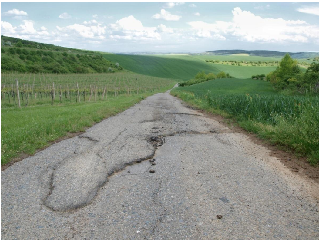
Obrázek 15: "Od rozhledny" - asfaltová polní cesta stojí přímo v dráze soustředěného povrchového odtoku a je jím opakovaně poškozována.
