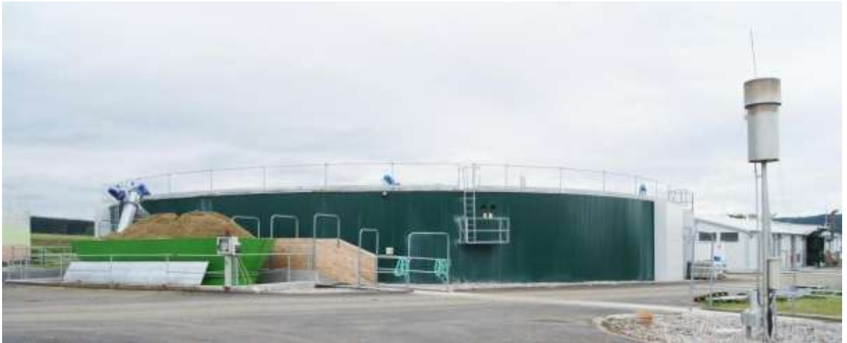
Obr. č. 20: Fotografie fermentoru bioplynové stanice
