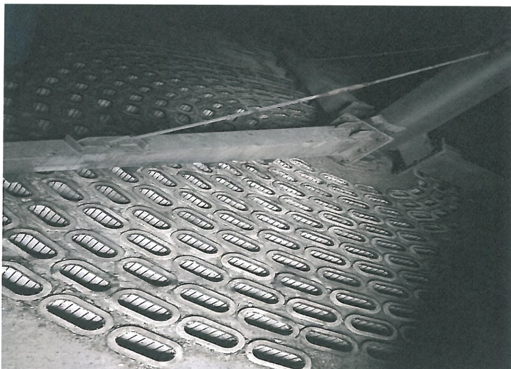
Obr.5. Tkaninové filtry pohled na čistý prostor
