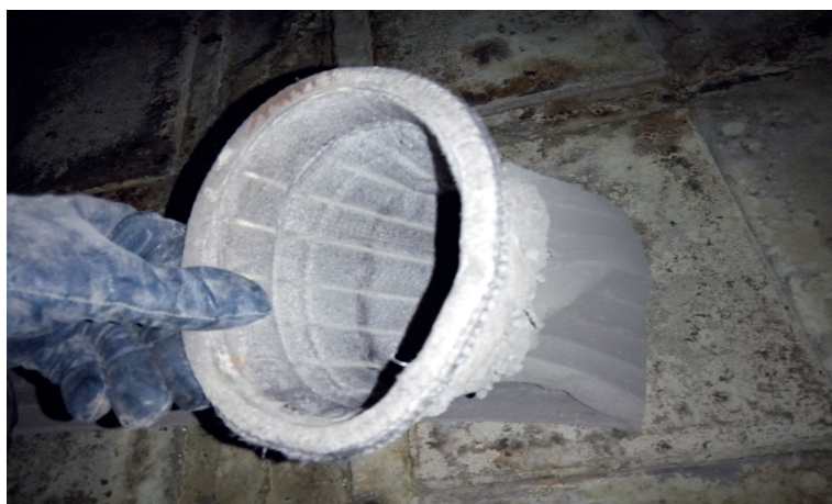
Obr. 8. Rukávový textilní filtr spalin, nejlepší dostupná technika BAT – Best Available Techniques.
