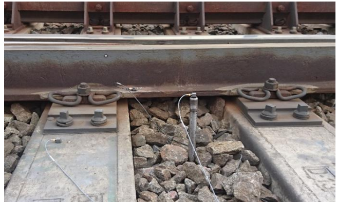
Obrázek 10 Pohled na upevnění ve výhybce č. 3
