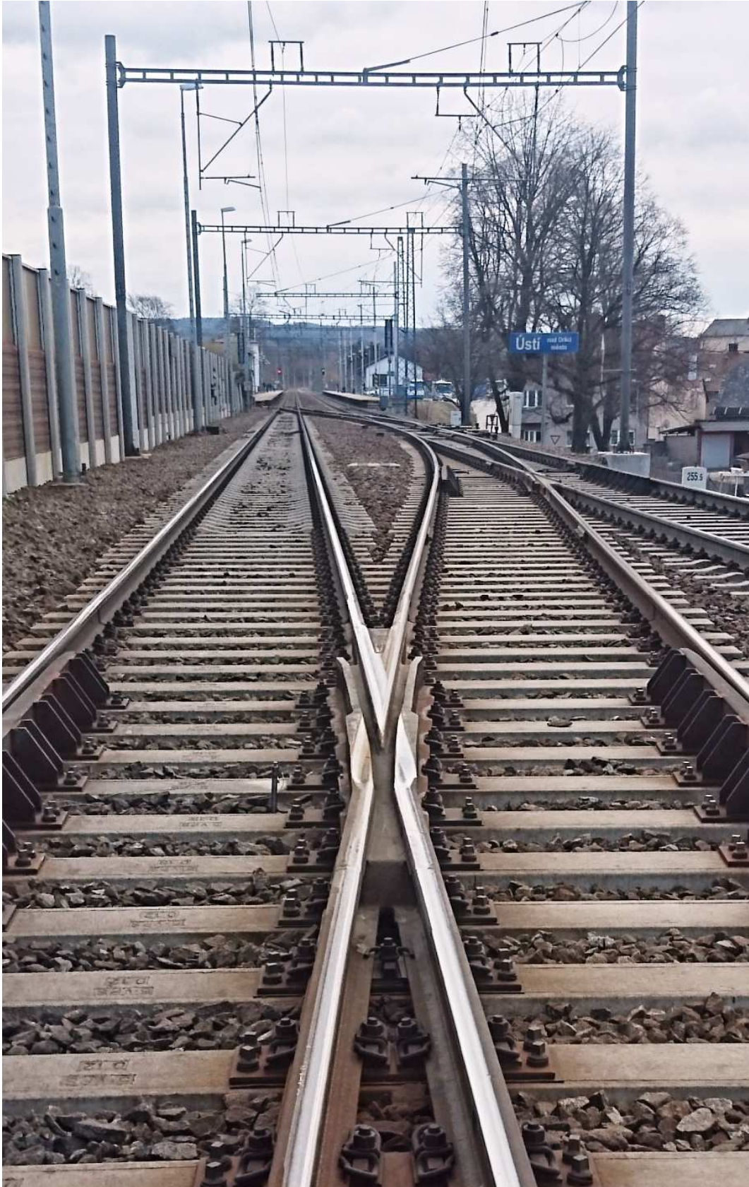
2 Pohled na srdcovku výhybky č. 4
