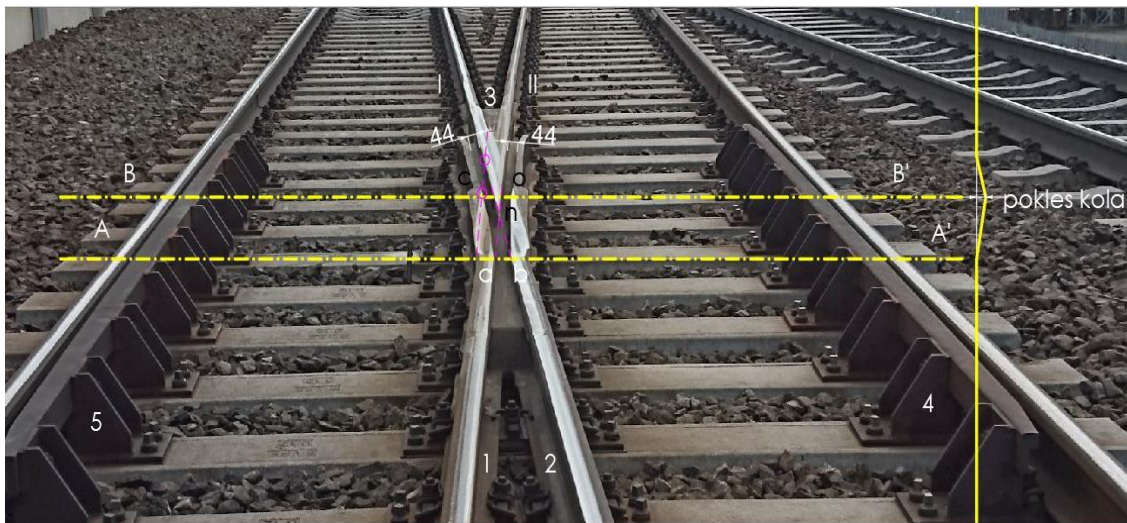
Obrázek 2 Rozdělení srdcovky v charakteristických řezech popisujících průjezd dvojkolí srdcovkou
