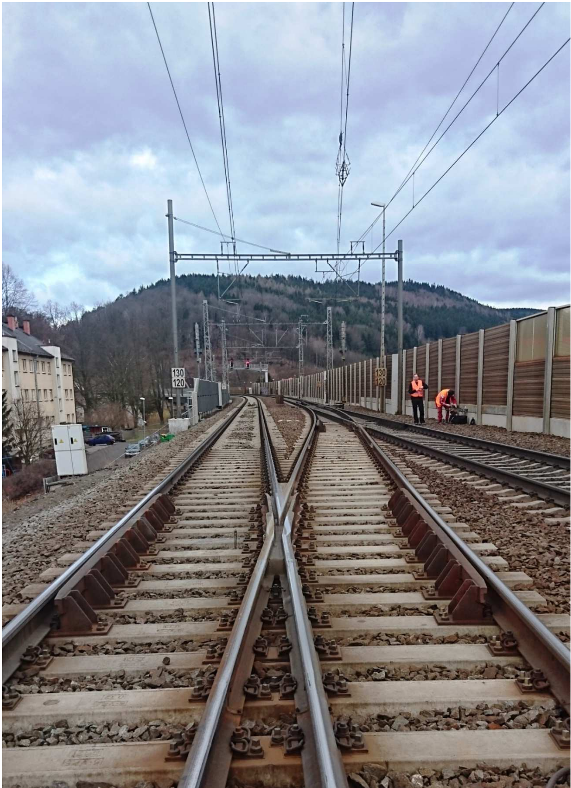
1 Pohled na srdcovku výhybky č. 3
