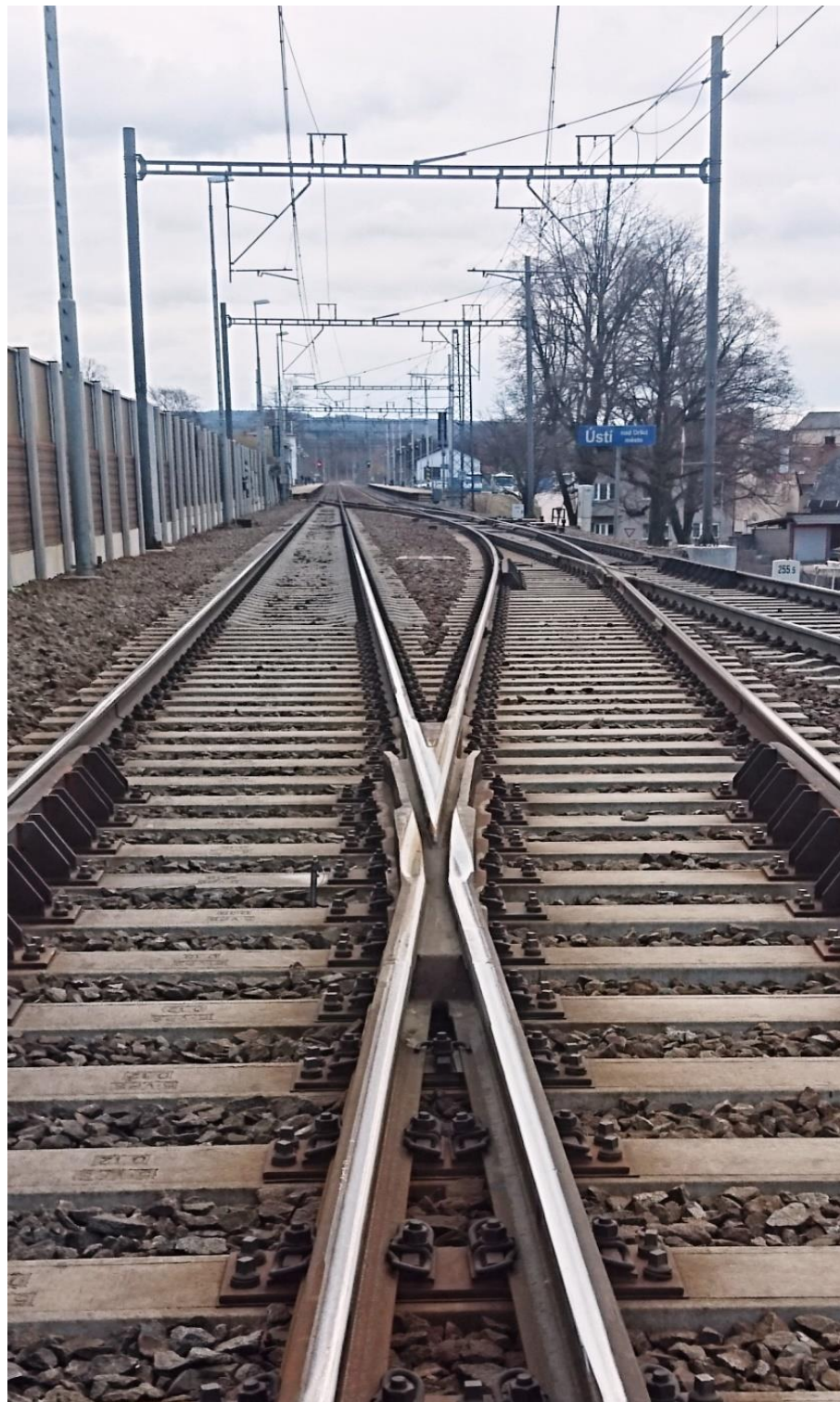
Obrázek 13 Pohled do železniční stanice na srdcovku výhybky č. 4
