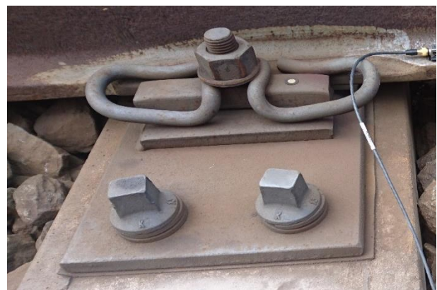
Obrázek 11 Pohled na upevnění ve výhybce č. 4
