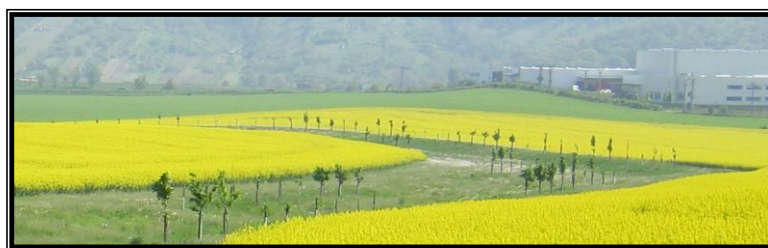
Obr. 3: Protierozní průleh na jižní Moravě (Horáková, květen 2010)
