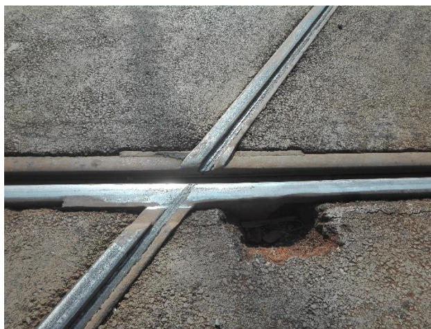
Obr. 5.3. Rýha na temeni kolejnice
