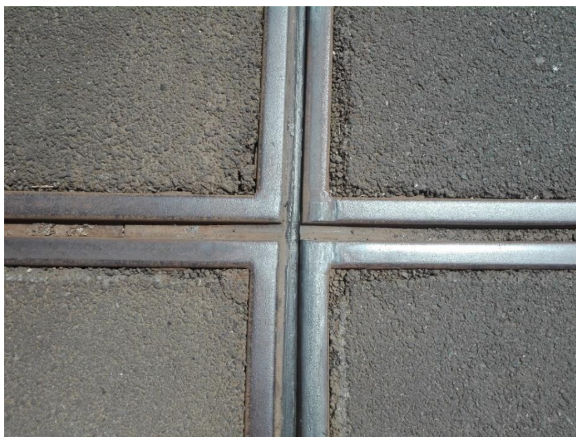
Obr. 9.2. Vyvaření obou na sebe kolmých žlábků
