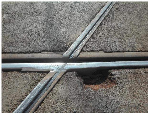
Obr. 5.3. Rýha na temeni kolejnice
