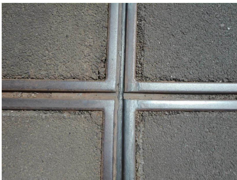
Obr. 9.2. Vyvaření obou na sebe kolmých žlábků
