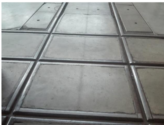
Obr. 7.1. Výhybkárna DT Prostějov
