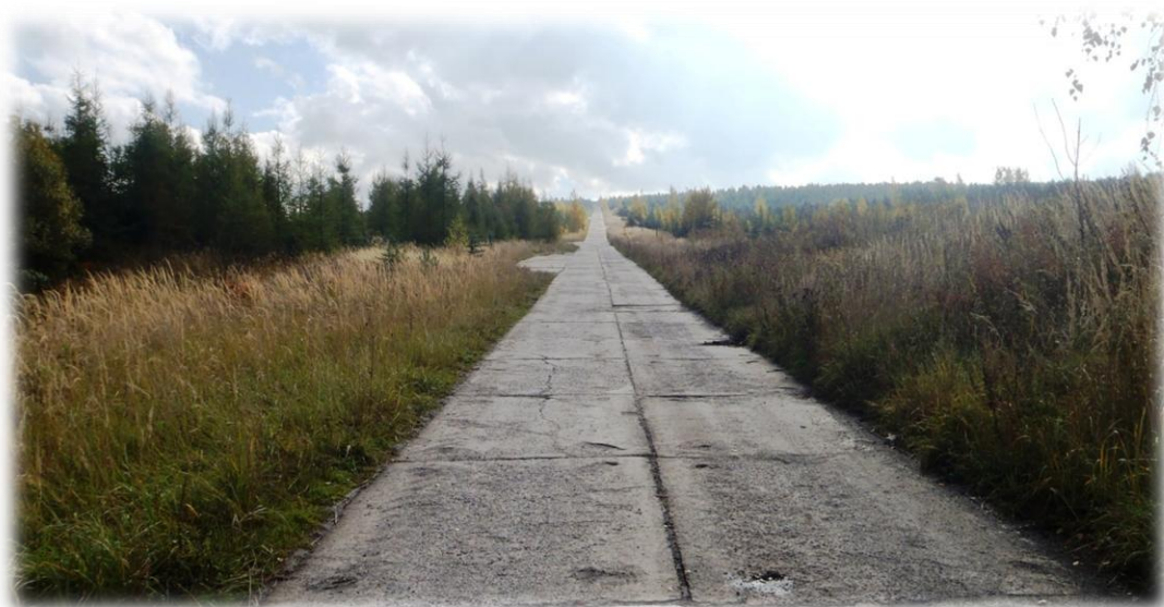
Fotografie č. 7 Panelová cesta přes výsypku
