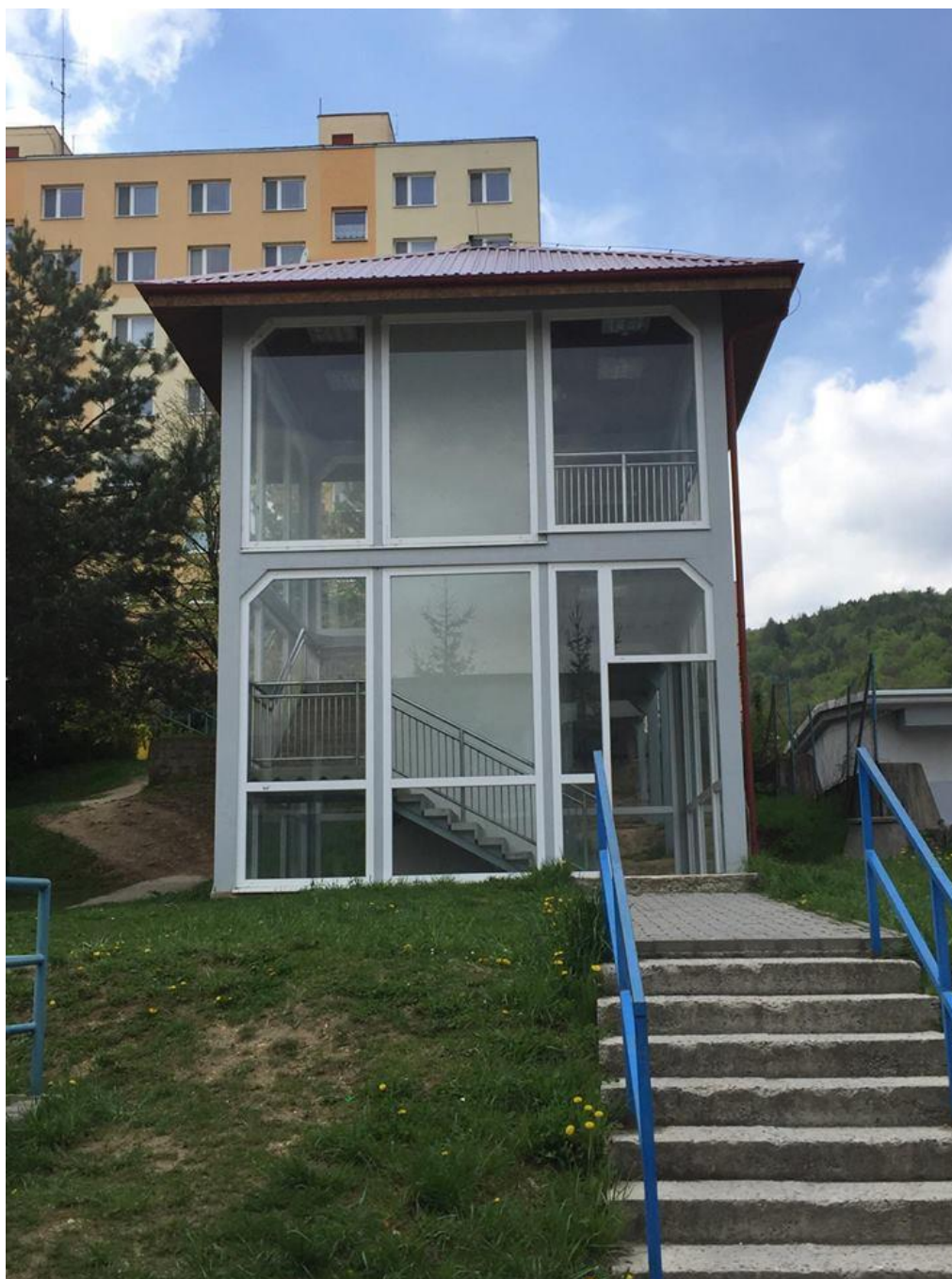
Obrázok 18 - Objekt bezbariérového prístupu s výťahom
