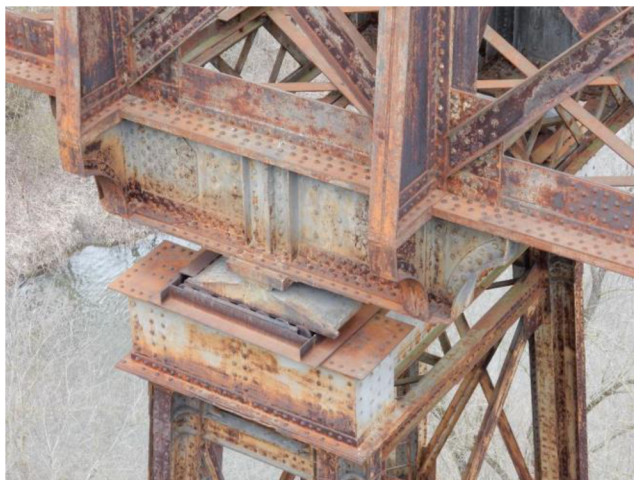
Obr. 3.2 Detail uložení skutečného stavu mostu
