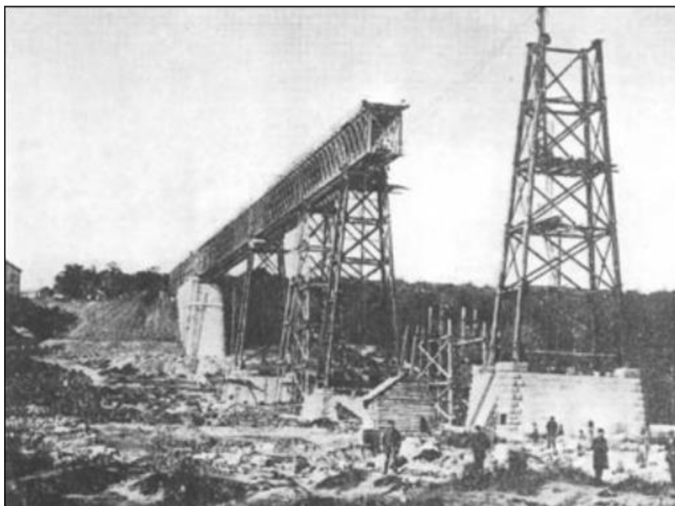
Obr. 2.2 Historická fotografie ze stavby mostu [5]
