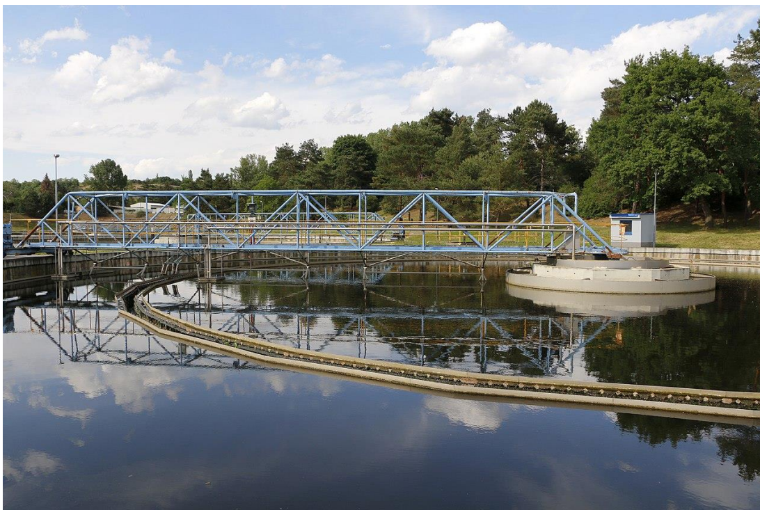
Obrázek 17: ÚČOV dosazovací nádrž
