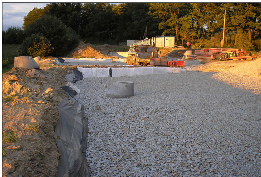
Obr. č. 2: Stavba kořenové čistírny Roseč
