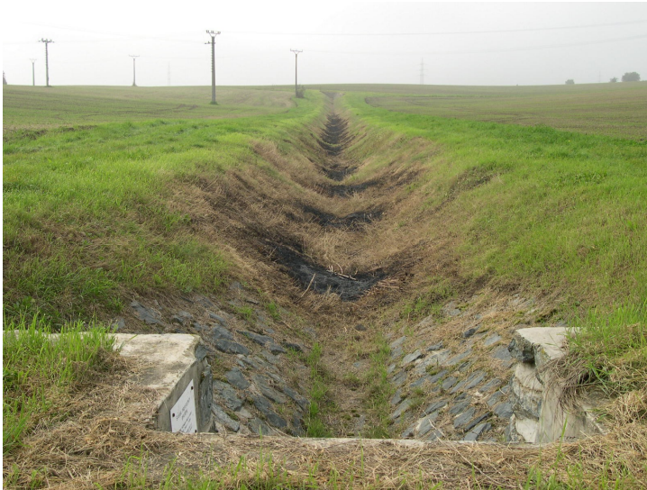
Obr. č. 9: Svodný příkop „A“ od vtokového objektu u příjezdové cesty z obce Vážany nad Litavou (Autor: M. Prášek, 2010).
