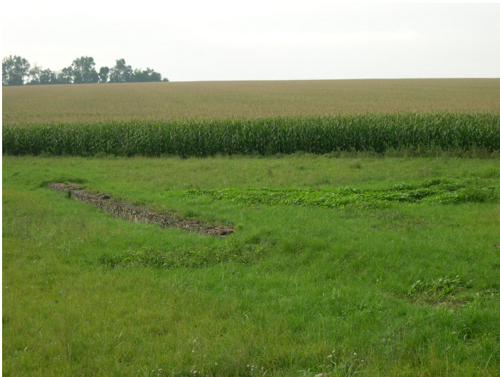
Obr. č. 23: Zanesená hrázka z gabionů nad zátopou poldru P1 (Autor: M. Prášek, 2010).
