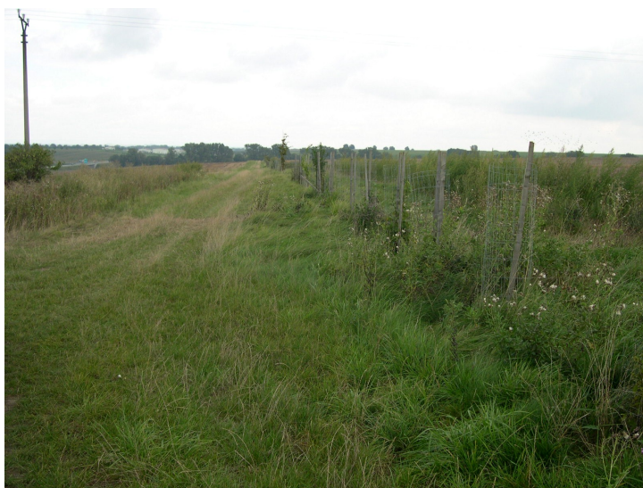
Obr. č. 15: Zasakovací pás P2, ve směru od příjezdové cesty Cd2 (Autor: M. Prášek, 2010).
