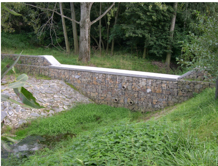
Obr. č. 28: Přehrážka 2, pohled od příjezdové cesty z obce Boškůvky (Autor: M. Prášek, 2010).
