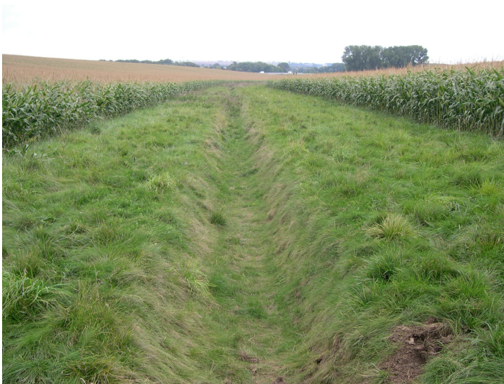
Obr. č. 11: Svodný příkop U1, pohled od začátku (Autor: M. Prášek, 2010).
