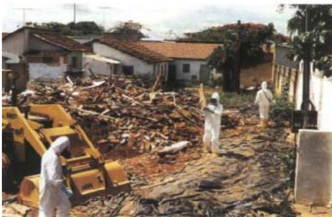
Obrázek 16: Demolice kontaminovaných domů v Goiânii (IAEA, 1988)
