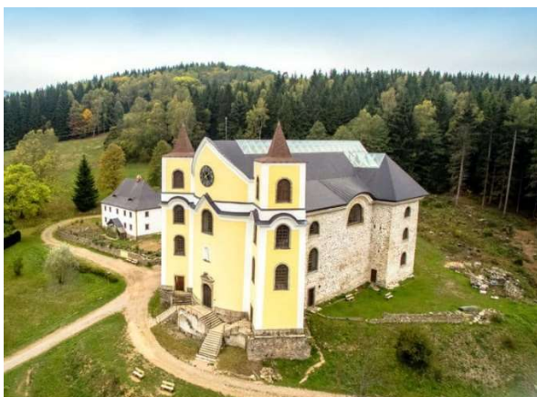
Obrázek 15 Kostel Nanebevzetí Panny Marie se skleněnou střechou Neratov
