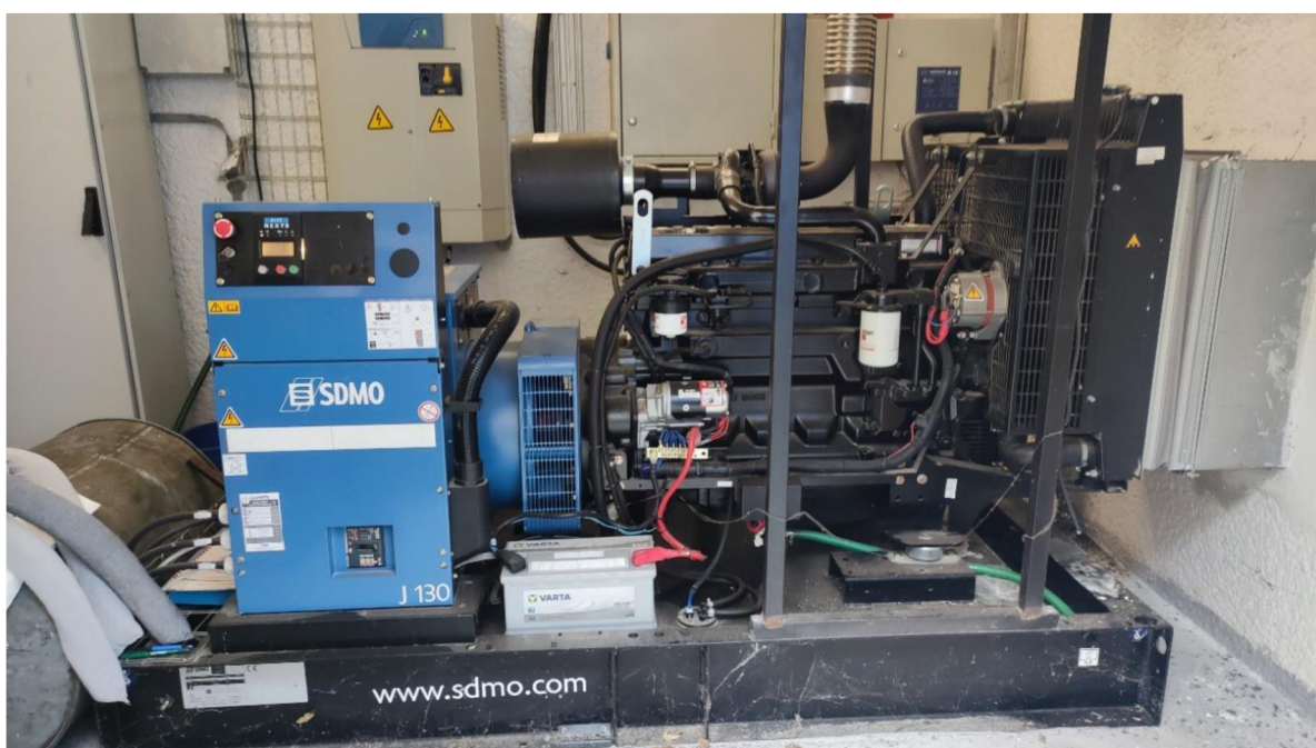
Obrázek 6 Diesel agregát v budově tavírny
