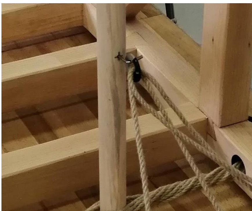
Obrázek 17 Detail vystřelovacího oka. Interní zdroj
